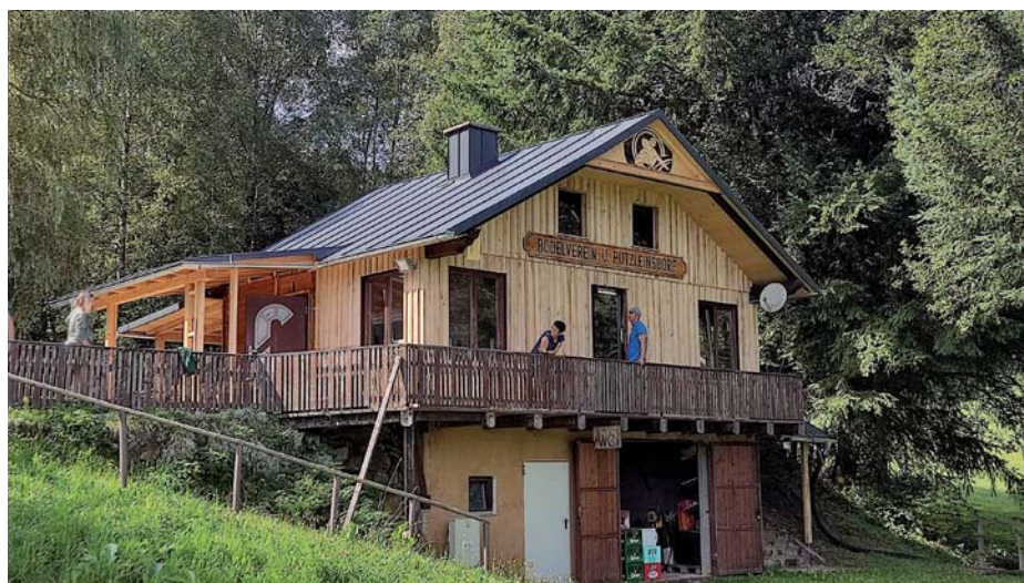
Sanierungsarbeiten am Zielhaus des Rodelvereins
